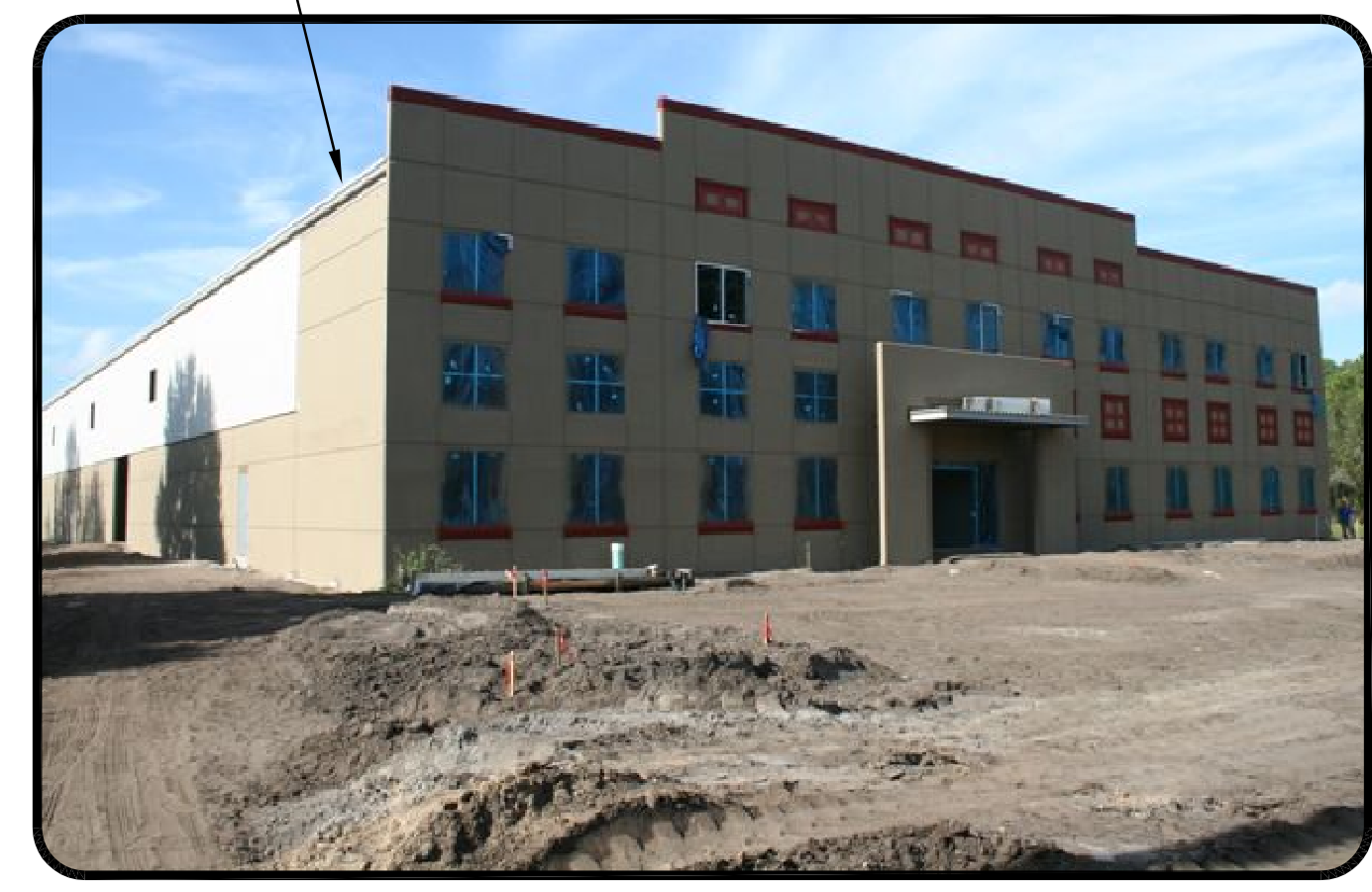
02 BUILDING PHOTOGRAPH SCALE: N.T.S.
